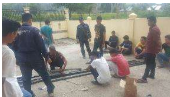
Gambar 7. Proses Pemotongan Besi Stalbus
